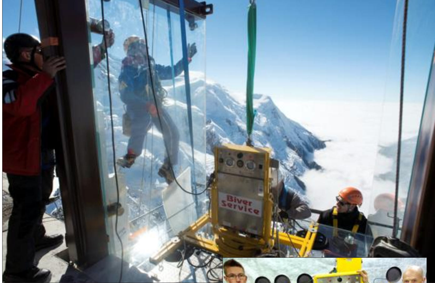
Biver service (le père et le fils en médaillon) a manipulé le verre du cube avec son palonnier à ventouses. Photo René ROBERT
