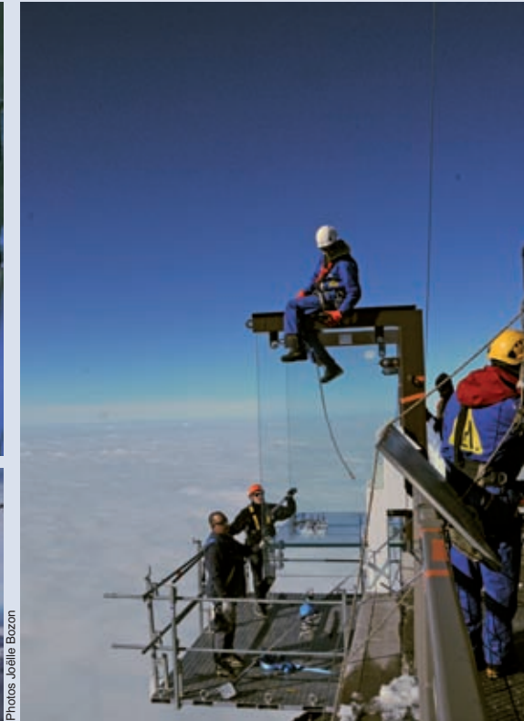
Pose du plancher vitré
